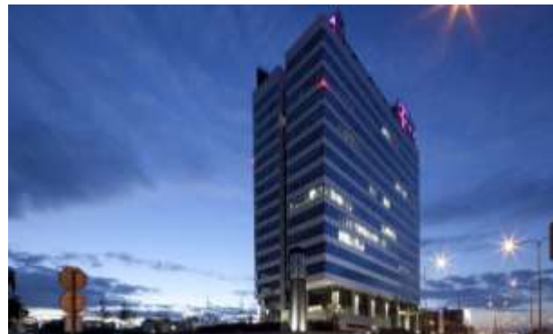
Administrativní budova Forum BC I, Bratislava, SR
