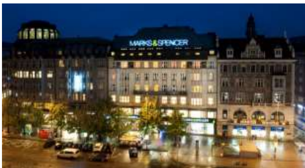
Multifunkční budova Melantrich, Praha, ČR
